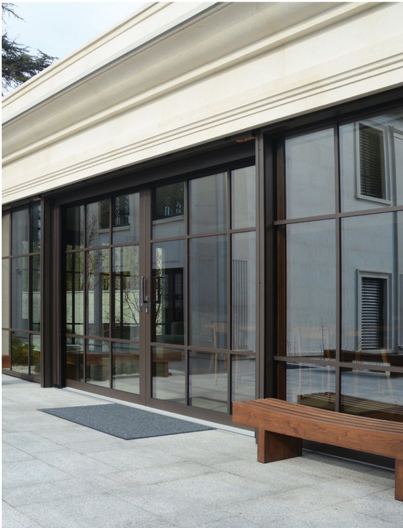
Podizno klizni sistem LS ATHi / stambeni objekat, Tolstojeva, Beograd
